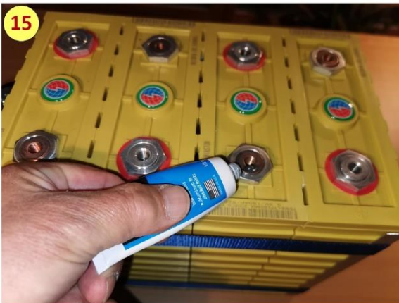
Sobald die 8 Pole sauber sind werden sie alle mit Noalox Polfett gegen weitere Korrosion geschützt.
