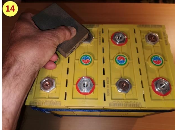
Jetzt säubern wir die Pole mit einem feinen Schleifschwamm (Körnung 100). Insbesondere die Kupfer Inserts haben meist eine Korrosionsschicht, die einige Geduld abverlangt.
