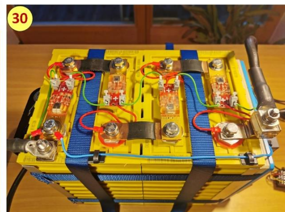
Wir haben nun einen kompakten, in sich stabilen Batterieblock, der kein separates Gehäuse benötigt. Die fertige Batterie ließe sich einfach mit Zurrbändern am Boden festmachen, wie man hier am Beispiel sieht.
