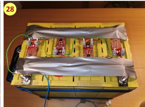
In gleicher Weise verbinden wir nun alle Zellmodule, indem wir die 3 grünen Leitungen, wie im Bild dargestellt, an den Federklemmen anschließen.
